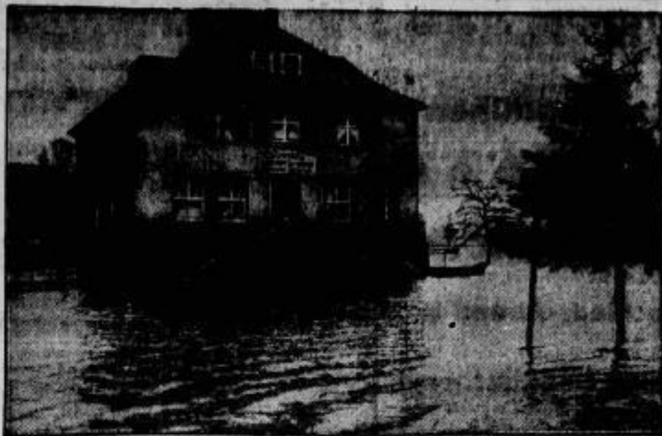
Schwaffer an der Ruhr. Infolge der ungewöhnlich starken Regenfälle, die das Wetter der letzten Tage über Nord- und Westdeutschland brachte, ist die Ruhr über ihre Ufer getreten und hat die anliegenden Ländereien überschwemmt. — Wir zeigen ein Haus bei Offen, das wie eine Insel im Wasser liegt.
