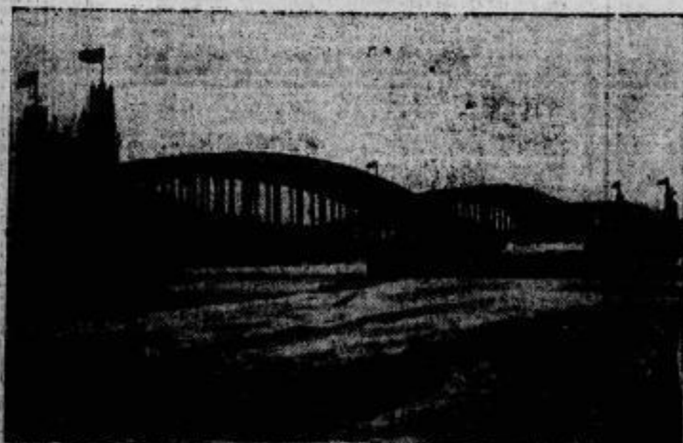
Die neue Brücke zwischen Hamburg und Gerdau. wurde am 5. Januar in Gegenwart preussischer und hamburgischer Regierungsvertreter dem Verkehr übergeben.
