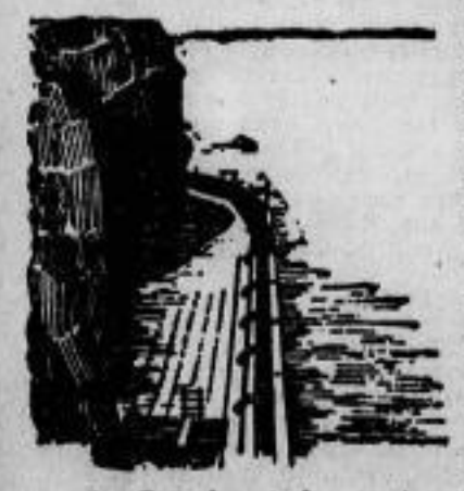
Ein Teil der starken westlichen Schutzmauer.
