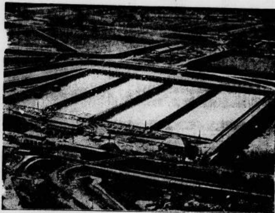
Kohle aus Flußschlamm gewinnt die Flußklärungsanlage der Emischer, eines Rhein-Nebenflusses, der das ganze Ruhrrevier von Ost nach West durchquert. Die Emischer führte aus dem Industriegebiet so bedeutende Kohlenabwässer dem Rheine zu, daß sowohl die Fischbestände wie die Trinkwasserversorgung erheblich beeinträchtigt wurden. Diesem Zustand hat die bei Arnay errichtete Klärungsanlage ein Ende gemacht, die jährlich über 100.000 Tonnen Kohlenabwasser aus dem Flußwasser gewinnt und dieses wieder vollkommen klärt. Die jährlich gewonnene Schlammmenge wird in etwa 100 Millionen Kilowattstunden elektrischer Kraft umgewandelt.
