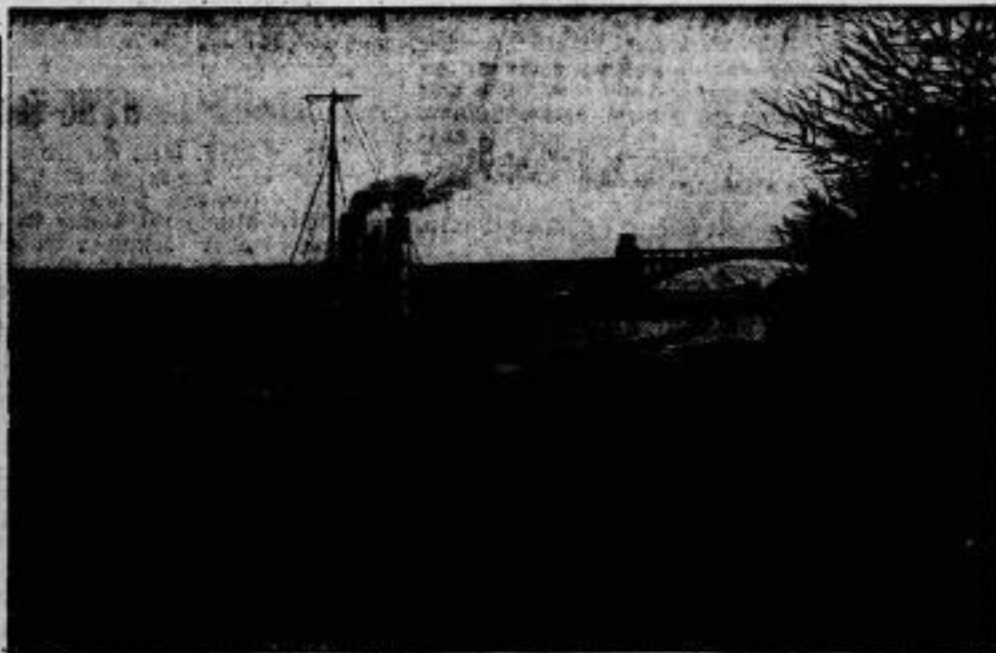
Russische Eisbrecher im Nord-Ostsee-Kanal. Der russische Eisbrecher „Jermak“ bei seiner Arbeit im Nord-Ostsee-Kanal, dessen 70-100 Zentimeter harte Eis durch deutsche Eisbrecher nicht mehr bezwungen werden konnte. (Im Hintergrund die Hochbrücke von Levensau.)
