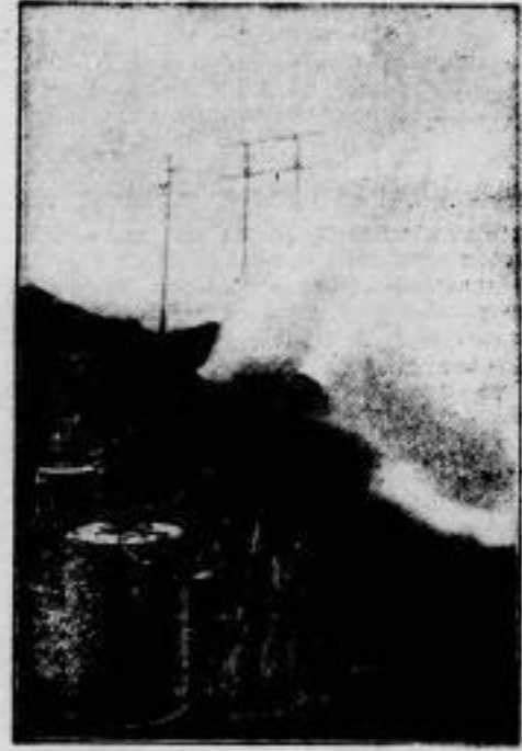
Deutschlands passiver Schutz gegen Luftangriffe. Vor den Mitgliedern des Ostpreussischen Städtetages wurde am 27. Mai die künstliche Einnebelung des Kraftwertes Friedland bei Königsberg durchgeführt, die die Möglichkeit des Schutzes derartiger lebenswichtiger Werke gegen Luftangriffe bestatigt. — Unser Bild zeigt Einnebelungshandgeräte in Tätigkeit.
