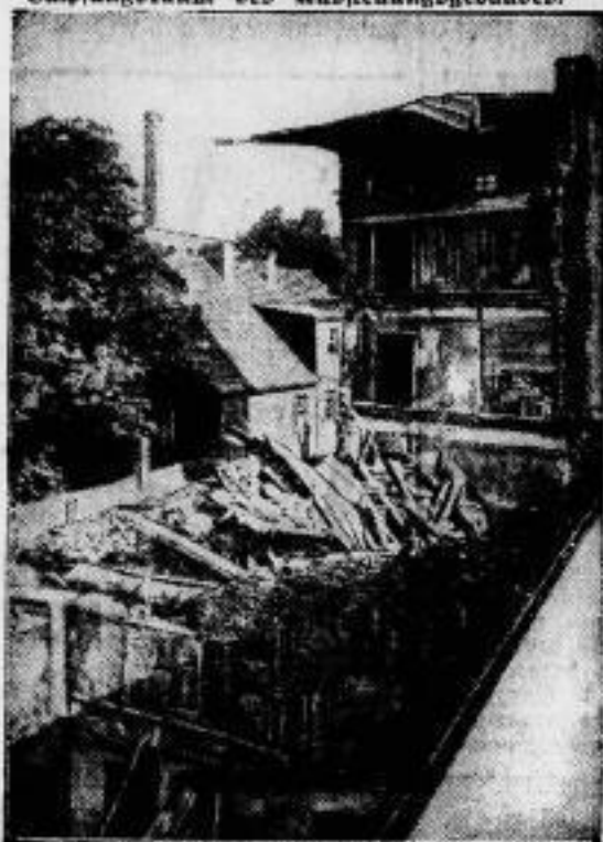
Wieder ein Hauselndur. In Forst in der Gausig Straße — ohne daß vorher irgendwelche Anzeichen wahrgenommen wurden, — ein vierstöckiges Haus in sich zusammen. Glücklicherweise waren keine Verluste an Menschenleben zu beklagen.
