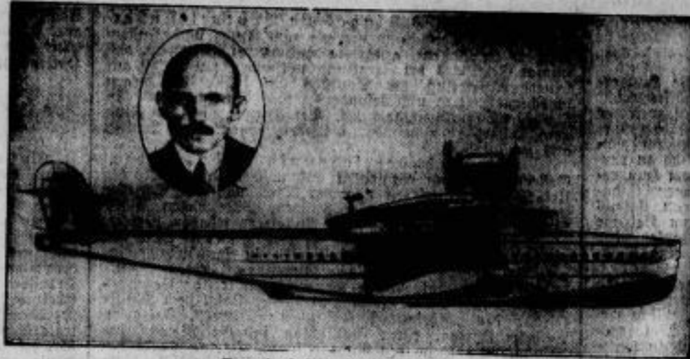
Dorniers Wunderflugschiff, das von den Dornier-Brüdern in Friedrichshafen (am Bodensee) erbautes Flugschiff 'D O X', ist fertiggestellt und wird in den nächsten Tagen vom Stapel laufen. Hier die Zahlen: Spannweite 48 Meter, Länge über 40 Meter, Höhe 10 Meter, zwölf Motoren von je 825 Pferdekraften, zusammen also 9900 Pferdekraften (das Luftschiff 'Graf Zeppelin' verfügt nur über 2750 Pferdekraften), Höchstgeschwindigkeit 250 Stundenkilometer, Fliegeschwindigkeit 190 Stundenkilometer, Raum für 127 Passagiere. Alles in allem: das Oceanflugschiff der Zukunft! — Im Oben: der Konstrukteur von 'D O X', Dr. Dornier.
