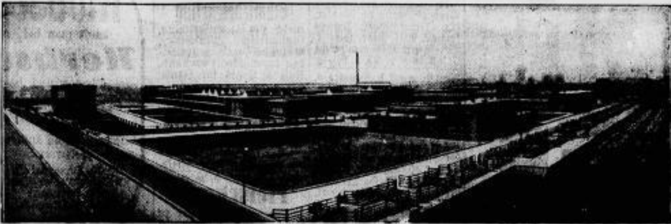
Stätten der Arbeit. Der neue Schlacht- und Viehhof in Bochum, die größte und modernste derartige Anlage in Westdeutsch- land, die vor einigen Tagen ihrer Bestimmung übergeben wurde.
