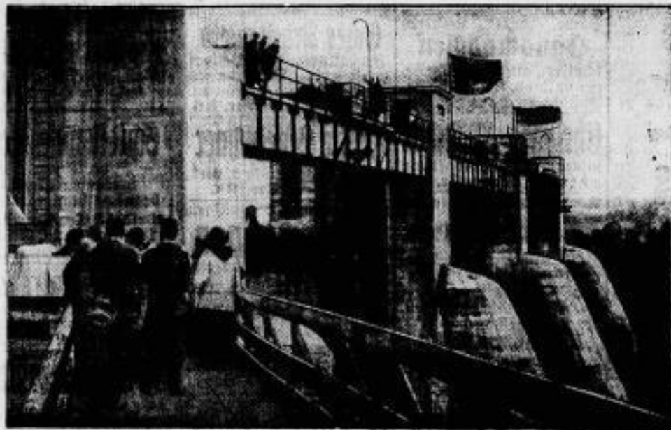
Die Einweihung des Schannan-Kraftwerkes in Irland, das — durch deutsche Ingenieure und deutsche Arbeiter er- richtet — einen Triumph deutscher Technik bedeutet — fand dieser Tage statt. Bisher wurde nur ein Teil der riesigen Anlagen in Betrieb genommen.
