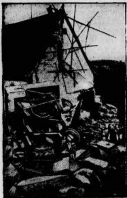
Einsturz eines Kirchturmes. In Welsenburg bei Konstanz stürzte der erst vor wenigen Jahren renovierte und erhöhte Kirchturm in sich zusammen. Glücklicherweise kamen Menschen nicht zu Schaden.
