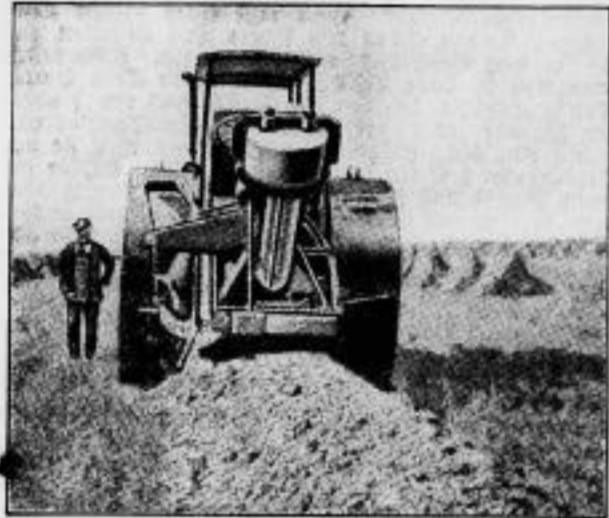
Mechanische Bodenmellorierung mit Motorkraft.
