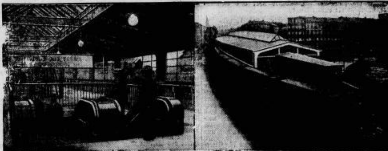
Berlin hat den größten und schönsten Hochbahnhof Europas bekommen, den am 4. August in Betrieb genommenen Bahnhof Kottbuser Tor, der mit seinen mächtigen, übereinanderliegenden Bahnsteigen ein Wunderwerk der Technik darstellt. — Rechts: ein Ueberblick über den Bahnhof. — Links: die Rolltreppen, die den Verkehr zwischen den einzelnen Stockwerken vermitteln.
