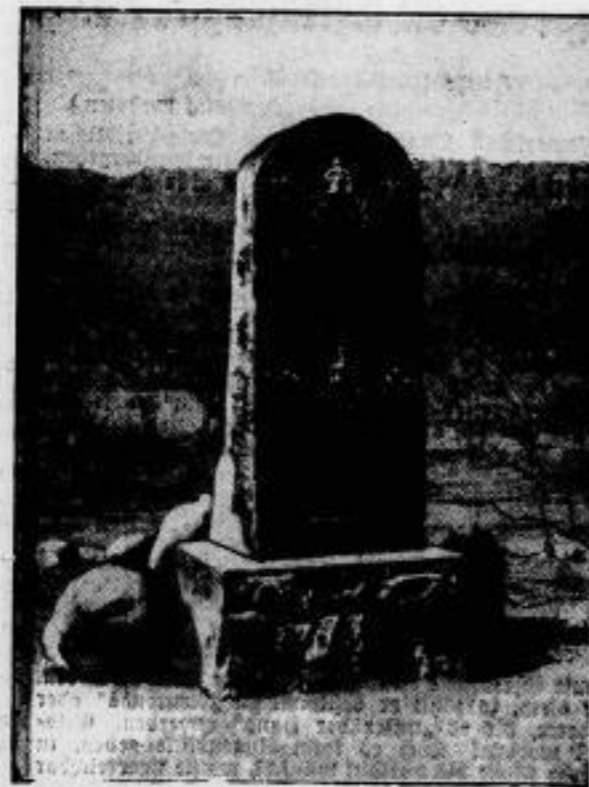
Das Denkmal für die Gefallenen der Schlacht am Waterberg, die — am 11. August vor 25 Jahren — mit dem Siege der Schutztruppe über die vereinigten Streitkräfte der Herero-Kämme das Ende des Aufstandes in Deutsch-Südwestafrika herbeiführte.
