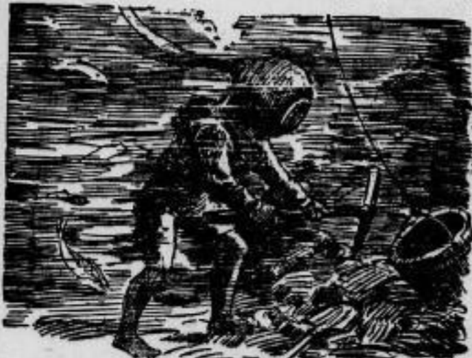
Mit Spitzhache und Schanzel steigt der Taucher auf den Grund des Flusses hinab...
