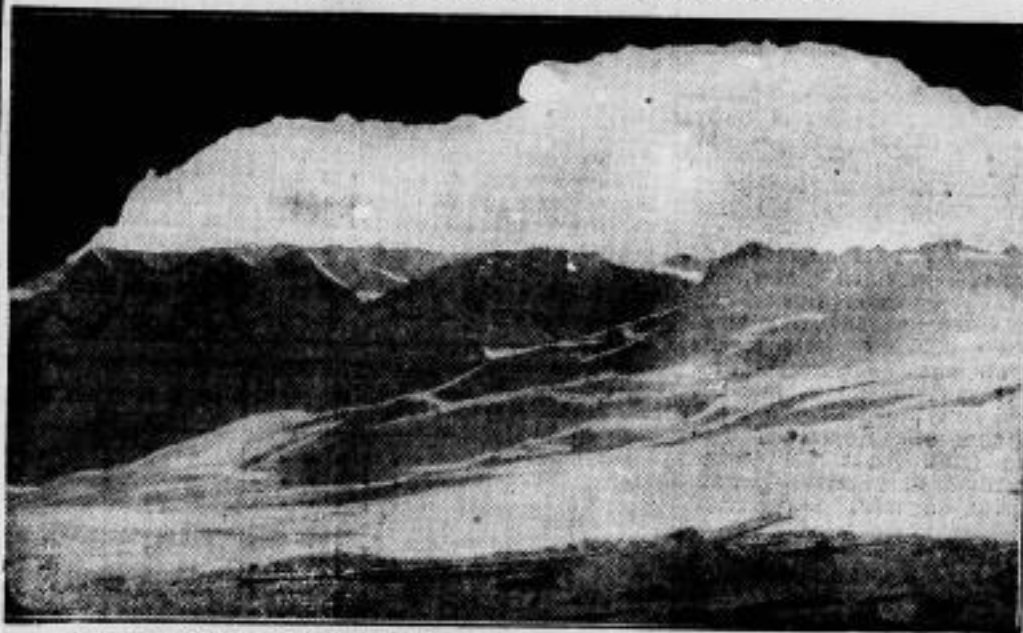
Der Durchschlag des Tunnels der Jungfernbahn zum Platzen.
