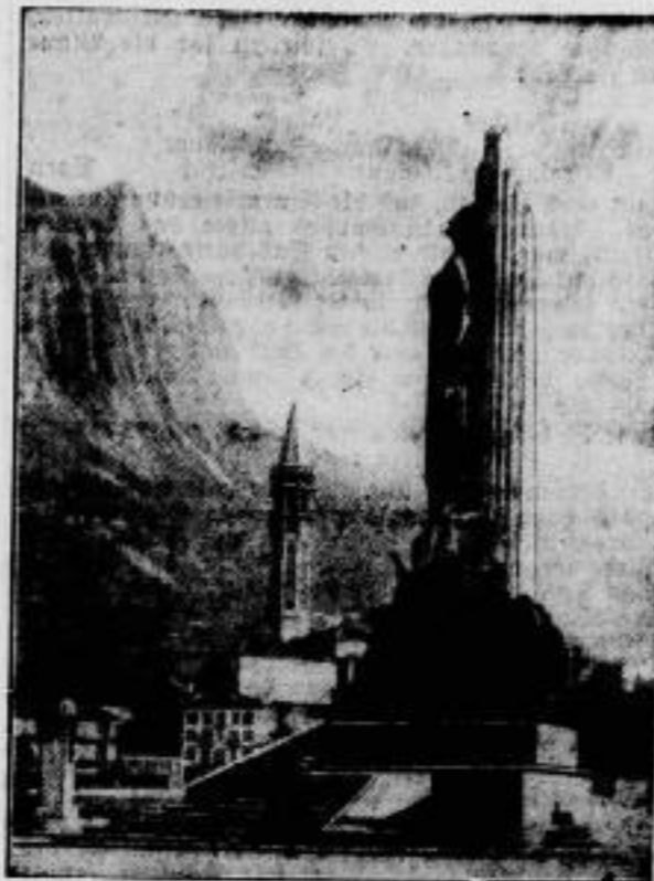
Italiens Dank an die Toten seiner Alpenjägerregimenter, ein Denkmal, das in Lecco, einer kleinen Stadt am Fuße der italienischen Alpen, errichtet wurde.
