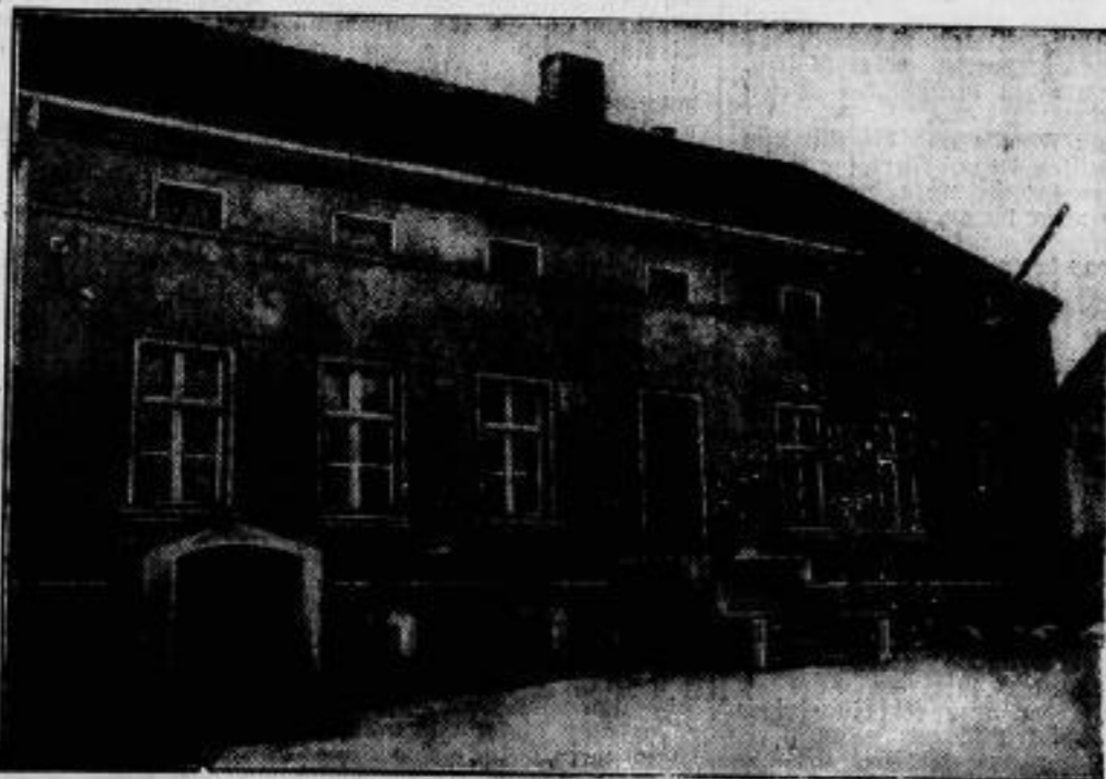
In diesem Hause 15 Jahre vom Bruder gefangen gehalten wurde in der Ortschaft Breesa bei Stenzig (Mark Brandenburg) ein Geisteskranker, der in einer Dachkammer (durch den Pfeil bezeichnet) ein gerades tierisches Dasein fristete. Die einzige „Aushaltung“ des Raumes war ein verfallener Strohsack, der Boden war mit Urrei bedeckt, das Fenster war vergittert und konnte nicht geöffnet werden. Der Bedauernswerte wurde in ein Krankenhaus übergeführt, sein unmenschlicher Bruder verhaftet.
