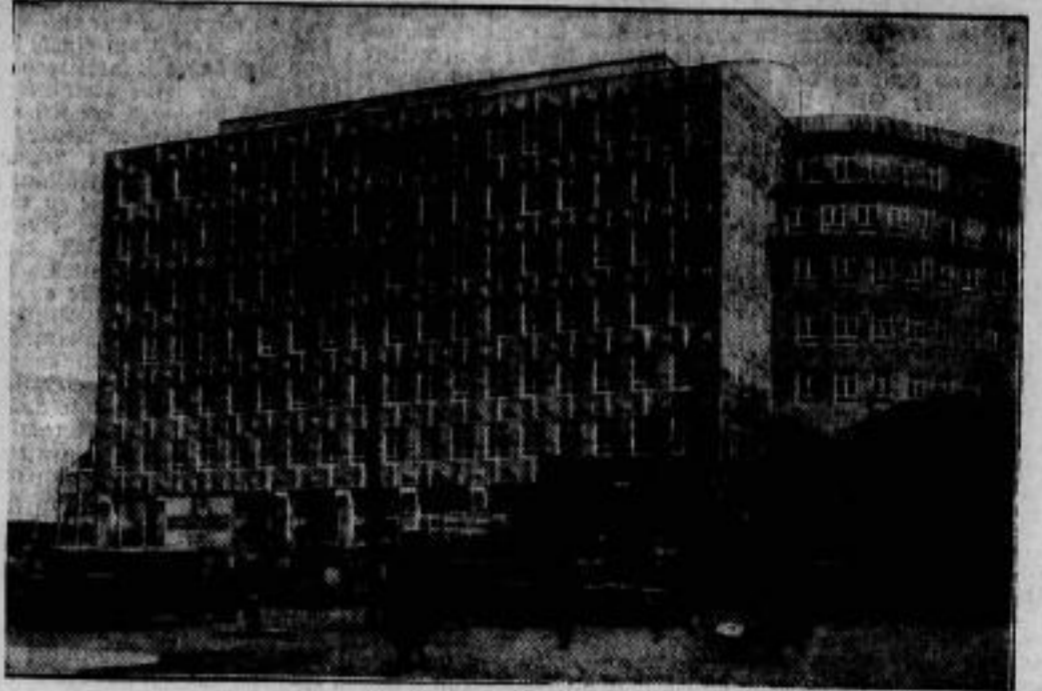
Ein neues Reichsbankgebäude in Hamburg steht kurz vor der Vollendung: der Sprintenhof, ein monumentales Bürohaus, das auf dem Boden der früheren Altstadt nach den Plänen des bekannten Architekten Fritz Höger in Sachsteinarchitektur errichtet wurde.
