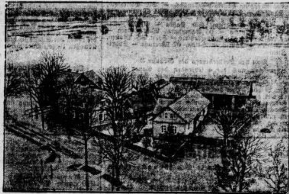
Aus dem schlesischen Heberschwemmungsgebiet. Ein Gehöft im Kreise A Josef, das aus den Fluten des Hochwassers wie eine Insel herausragt.
