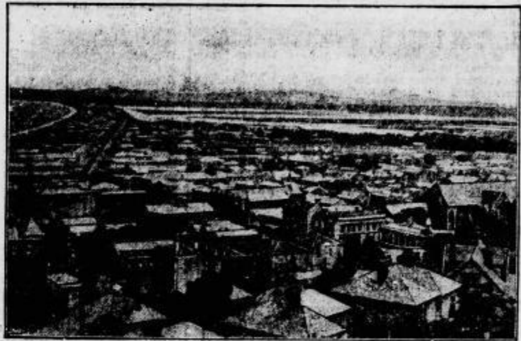
Das Opfer einer Erdbebenkatastrophe wurde am 2. Februar die Hafenstadt Kasper auf Kenia-Land: die meisten Häuser der Stadt stürzten ein, durch zahlreich ausbrechende Brände wurde eine Reihe von Dörfern in Flammen gesetzt, die Telegraphenlinien wurden zertrübert und der Meeresboden in der Nähe der Stadt senkte sich. Man rechnet mit Hunderten von Todesopfern.
