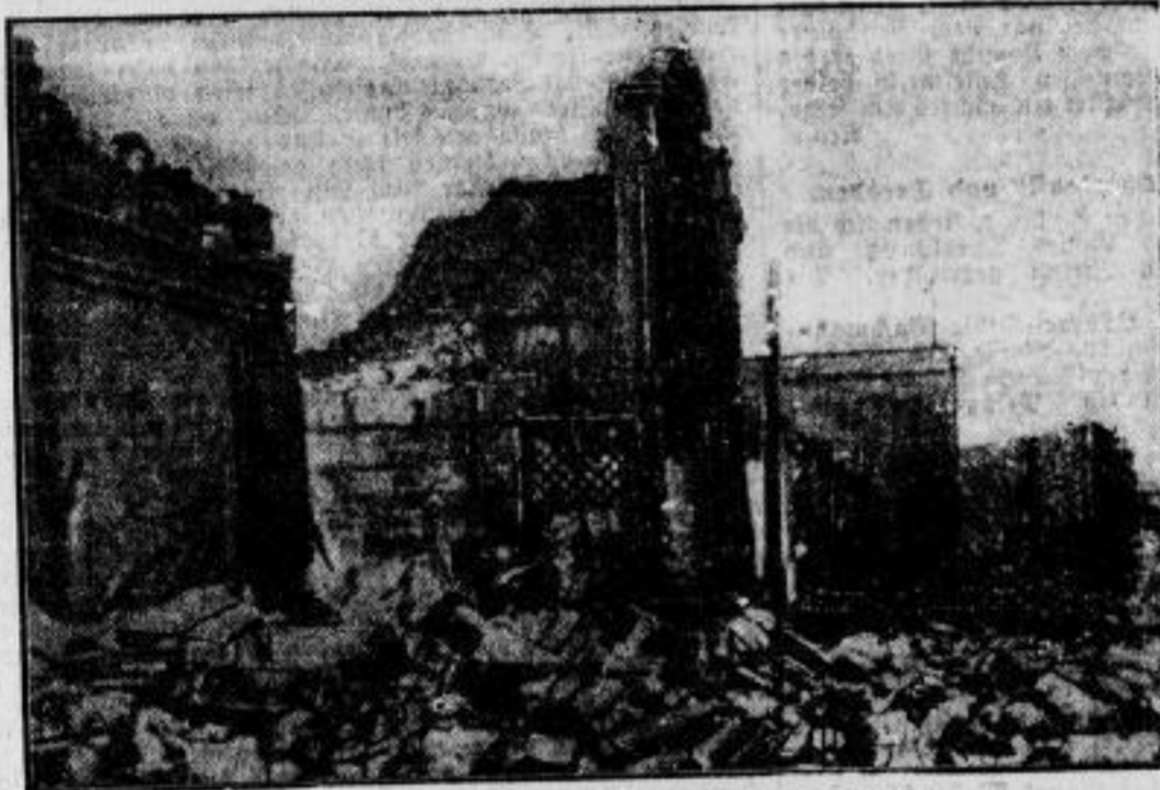
Das erste Bild von der Erdbebenkatastrophe in Neuseeland, die Anfang Februar mehrere Städte in Trümmer legte und 800-900 Menschen dahinraffte: eine Straße in der völlig zerstörten Stadt Napier.
