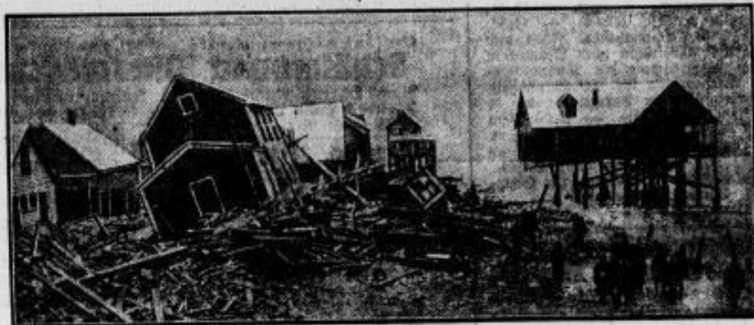
Die Zerstörungen einer Sturmflut bei Boston an der Ostküste der Vereinigten Staaten, wo kürzlich die dort den Strand begleitenden Holzhäuser durch Wind und Wellen zu Kleinholz geschlagen wurden.
