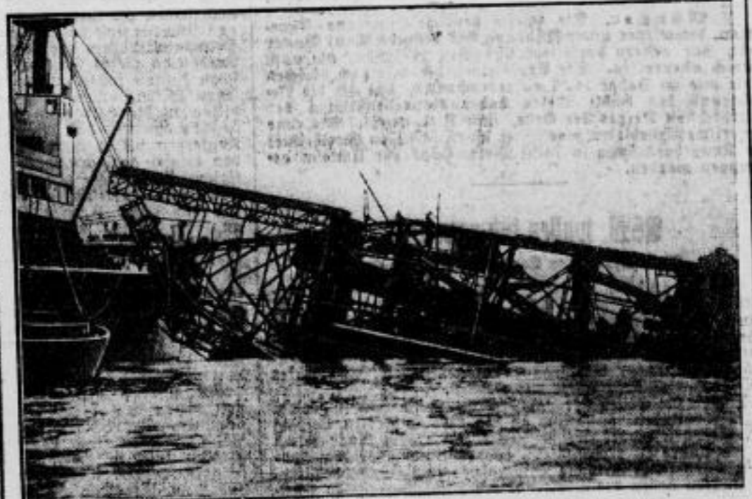
Eigenartiges Unglück im Hamburger Hafen. Im Hamburger Hafen ist dieser Tage ein 4000 Tonnen schwerer schwimmender Kohlenkran umgekippt und auf einen Dampfer aufgeschlagen. Unsere Aufnahme zeigt den schweren Schaden, der durch den aufschlagenden Kran auf dem Dampfer angerichtet wurde.
