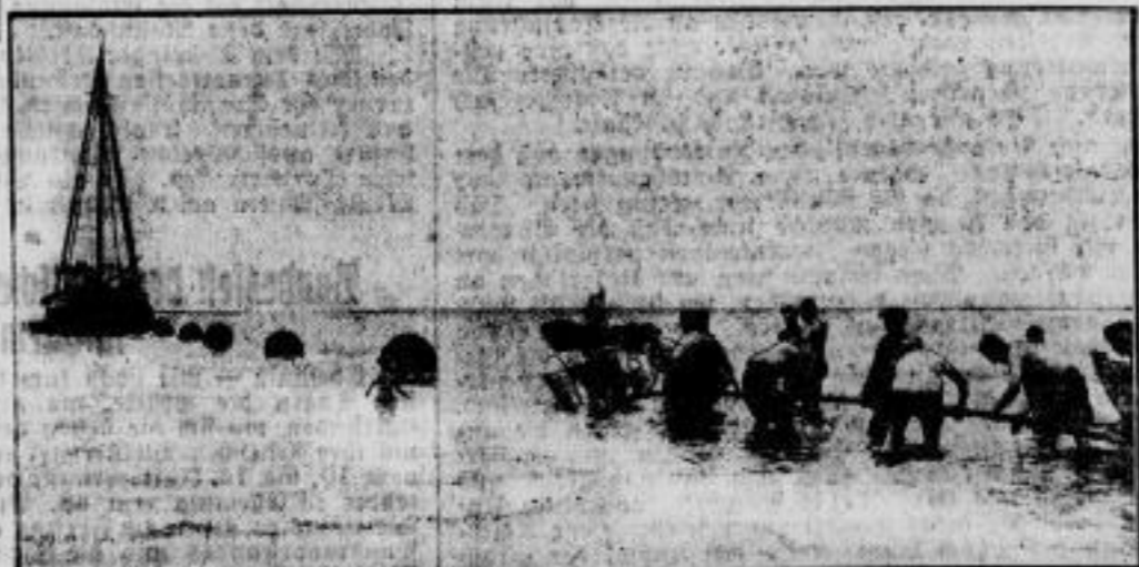
Das neue Fernsprechkabel Deutschland-Dänemark. In Warnemünde wurde das zweite Fernkabel zwischen Deutschland und Dänemark ausgelegt, das als Ersatz für das im Jahre 1926 ausgelegte Seekabel den ständig wachsenden Fernsprekverkehr zwischen Mitteleuropa und den nordischen Ländern in Zukunft aufnehmen soll. Bei dieser Gelegenheit wurde das alte, im Jahre 1888 gelegte Guttaperchakabel, das seinerzeit dem telegraphischen Verkehr diente und völlig unbrauchbar geworden war, aufgenommen.
