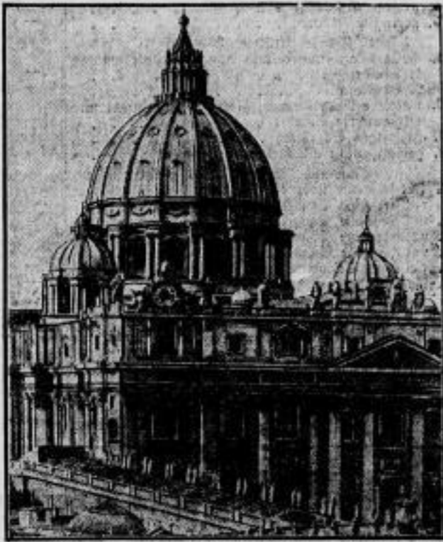
Die Kuppel von St. Peter wiederhergestellt. Bei Ausbesserungsarbeiten am St. Peters-Dom in Rom stellte man vor drei Jahren fest, daß die Kuppel des Domes bedeutende Sprünge aufwies. Auf Anordnung des Papstes wurden sofort umfassende Restaurierungsarbeiten unternommen, die jetzt zu Ende geführt wurden. Man hat große Cuadersteinblöcke ersetzt, in die Rippen Eisenbeton gegossen, und neu mit Asphalt belegt. Zur Erinnerung an diese größten Restaurierungsarbeiten, die seit dem Bestand der Petersbasilika an ihr vorgenommen wurden, hat man in einen Stein den Namen Papst Pius' XI. und das Regierungsjahr eingetragen.
