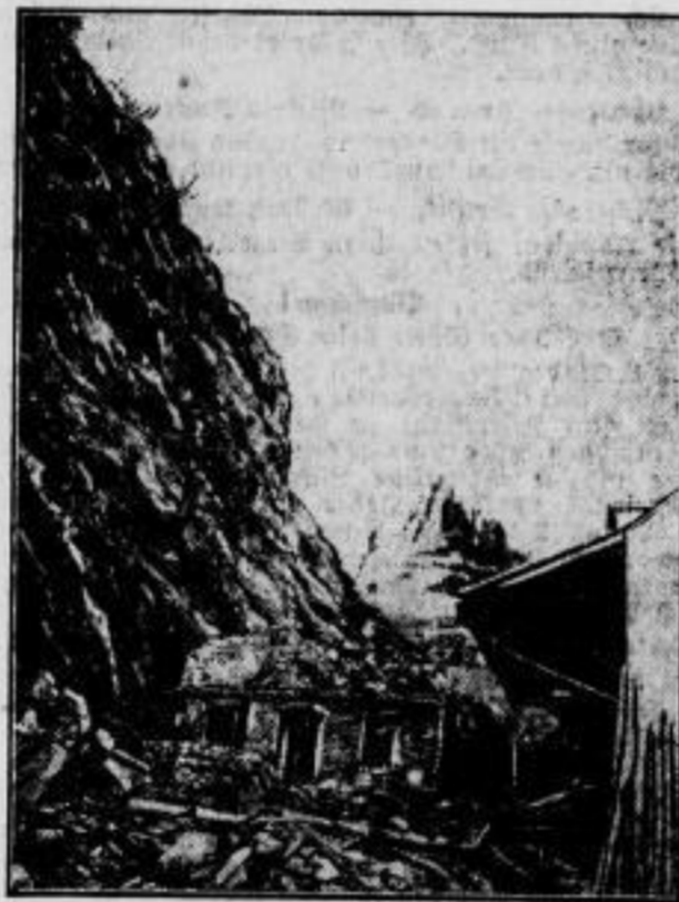
Der neue Felssturz am Cöckener Berg, von dem sich bereits im Frühjahr große Felsmassen losgelöst hatten. Bei diesem letzten Sturz sind über 1000 Kubikmeter Gesteinsmassen, darunter Felsblöcke von 60 Zentner Schwere, aus 100 Meter Höhe abgerutscht. Glücklicherweise waren die Häuser am Bergabhang bereits vor einigen Monaten geräumt worden.
