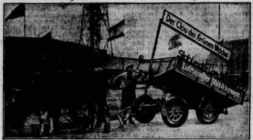
Neue Technik auf der Grünen Woche. Auf der jetzt stattfindenden Grünen Woche in Berlin ist ein Wagen für die Landwirtschaft zu sehen, der durch die Anwendung von Autobereifung nur ein Drittel der bisher benötigten Zugkraft braucht. Der Wagen hat einen Aufbau aus Stahl und besitzt auch eine Rippvorrichtung.
