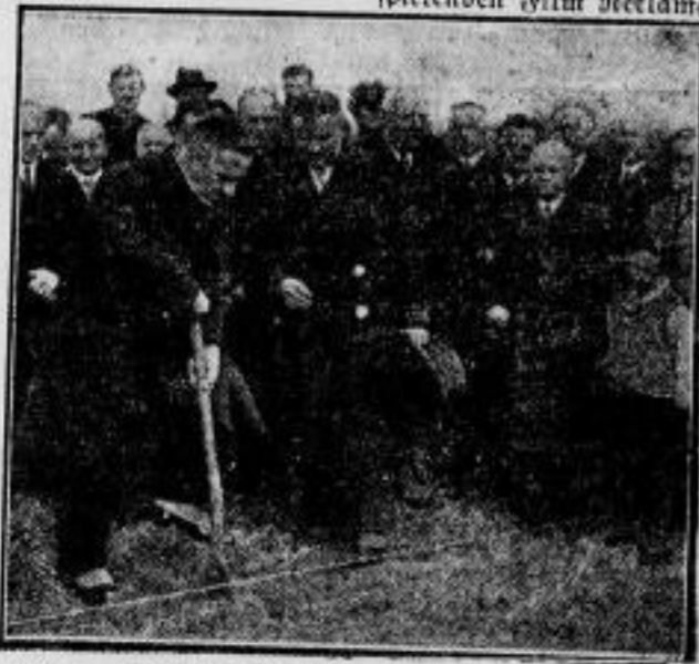
Hier entsteht Berlins erste Erwerbslosenbildung. Der Reichskommissar für das Siedlungswesen, Dr. Saffert, tut den ersten Spatenstich zur ersten Erwerbslosen-Stadtrand-Siedlung, die auf einem 70 Morgen großen Gelände in Marienfelde 6. Berlin entstehen soll.
