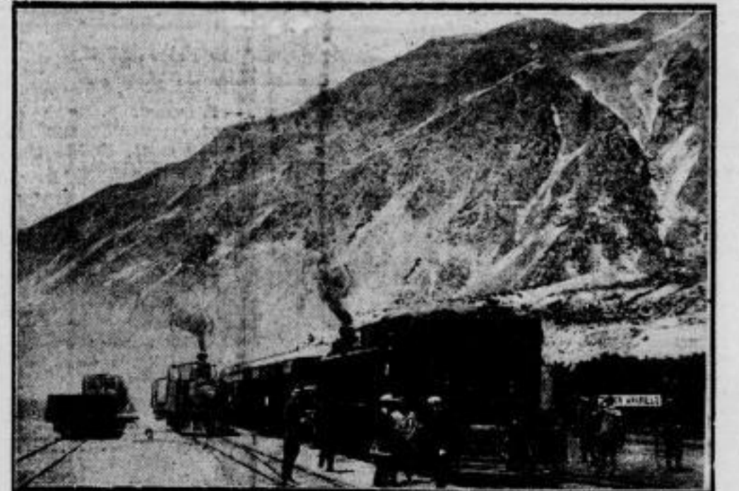
Tunnel-Einsturz beim Bau der neuen Anden-Bahn — 42 Tote.
