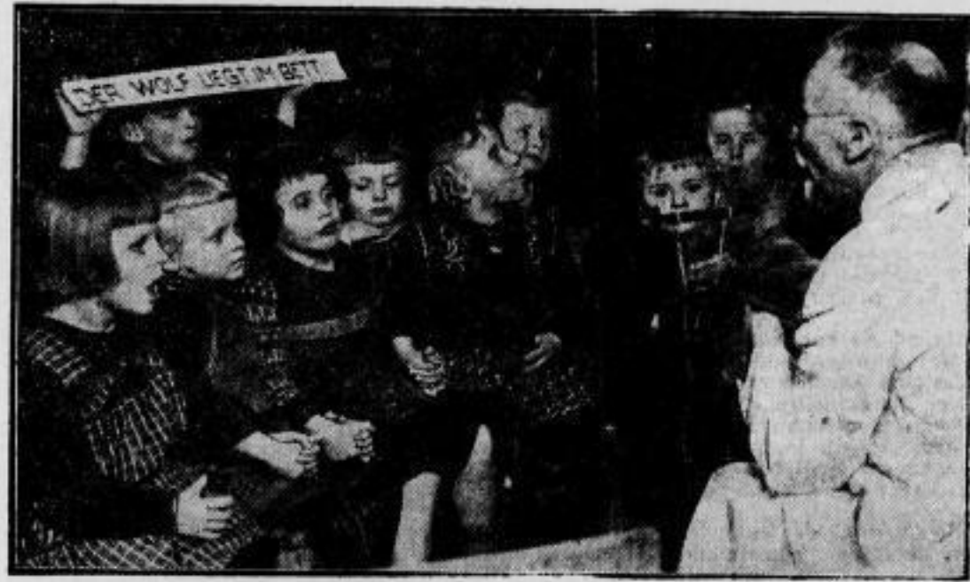
Taubstumme lernen mit den Händen „hören“! Im Staatlichen Heil- und Erziehungsinstitut in Leipzig hat man jetzt jahrzehntelange Versuche, Taubstumme hören zu lassen, erfolgreich zu Ende geführt. Mit Hilfe eines kleinen Radiosenders wird die normale Sprache in elektrische Schwingungen umgewandelt, die die Taubstummen mit den Händen „abhören“. Jeder Stromstoß entspricht einem andern Ton, und nach längerer Übung verstehen die taubstummen Schüler diese eigenartige „Sprache“ fließend. Wie unser Bild zeigt, sind
