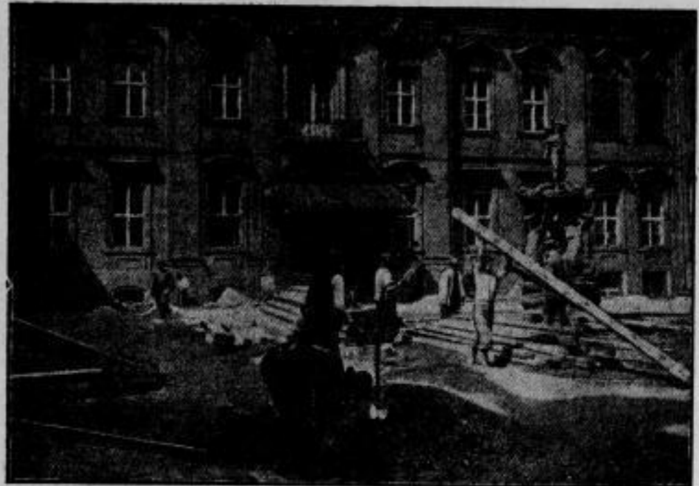
Der Umbau des Reichspräsidentenpalais. Das Palais des Reichspräsidenten in Berlin wird gegenwärtig in allen Teilen ausgebessert, da bedeutende Erneuerungsbauarbeiten sich als notwendig erwiesen haben.
