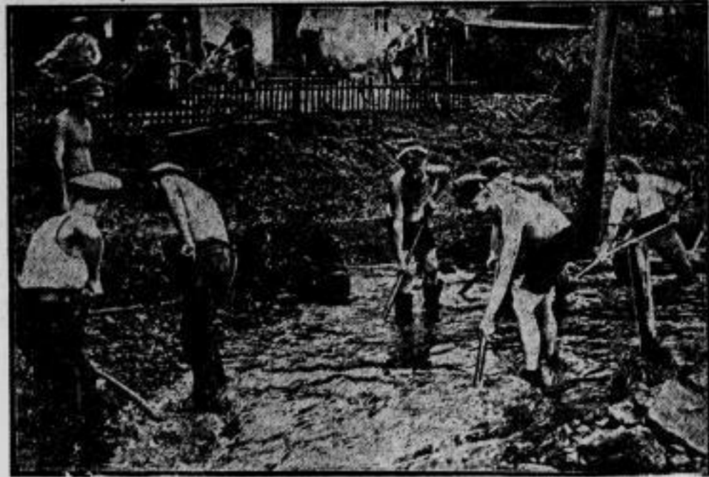
Freiwilliger Arbeitsdienst bei Hochwasser. Bei einer Hochwasserkatastrophe in der Gegend von Bauen wurden Arbeitsfreiwillige zu Rettungsarbeiten und zur Ausführung von Notstandsarbeiten eingesetzt. Unsere Aufnahme zeigt die freiwilligen Helfer beim Entfernen von angeschwemmten Steinen und Schlamm aus einem Bach nach dem Unwetter.
