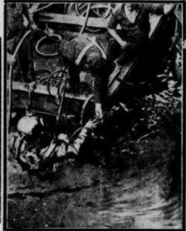
Taucher arbeiten an der „Niobe“. Nur ganz langsam gehen die Bergungsarbeiten an der „Niobe“ weiter. Die durch hohen Wellengang erschwerten Taucherarbeiten werden von dem bekannten Taucher Harmstorf geleitet. Unser Bild zeigt ihn, wie er mit einem Sauerstoffschnelzer in die Tiefe geht.
