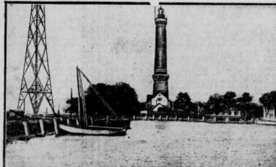
Der Leuchtturm von Swinemünde in Gefahr? Der Leuchtturm von Swinemünde bei Ostvorpommern ist ernstlich gefährdet, da das Bollwerk durch den dauernden Ein- und Ausstrom der Swine über fünfzehn Meter unterpült worden ist. Obgleich man bereits in den vergangenen Jahren große Senfstücke an den gefährdeten Stellen angebracht hatte, die die Unterpülung verhüten sollten, hat die Strömung ihr Zerstörungswerk unaufhaltsam fortgesetzt. Man will nun das Bett der Swine beim Leuchtturm erheblich erweitern und den Strom in ein gerades Bett leiten, um so den Anmarsch der Strömung gegen das Bollwerk zu vermindern.
