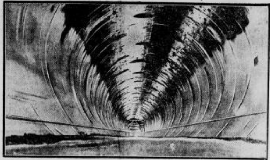
Durch diesen Riefentunnel werden sich die Fluten des Colorado-Flusses ergießen. In Amerika verfolgt man gespannt den Bau des Hoover-Dammes, eines riesigen Staubammes über den Colorado-Fluß, der eine Höhe von 300 Meter haben und die Gebiete am Colorado vor Ueberschwemmungen schützen soll. Auf unserem Bilde sieht man eines der riesigen Abfuhrrohre, die das Wasser des Colorado in das Staubecken—leiten werden.
