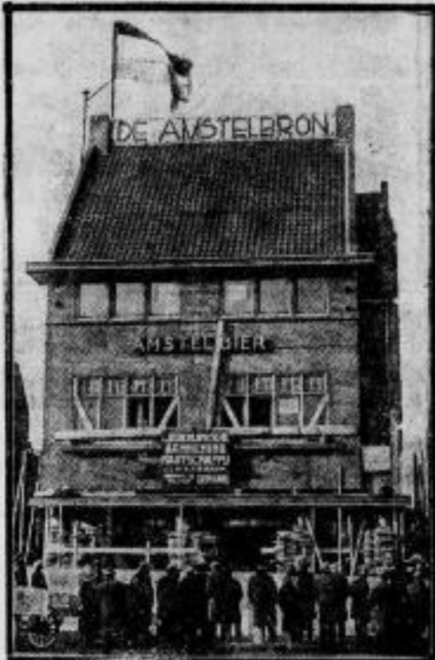
Ein Haus wird erhöht. In einer Straße des holländischen Städtchens Schiedam wurden die Häuser durch immer höher steigendes Grundwasser bedroht, so daß man — wie man aus unserm Bilde ersieht — einzelne besonders gefährdete Grundstücke emporhob, um sie vor dem Einsturz zu bewahren.
