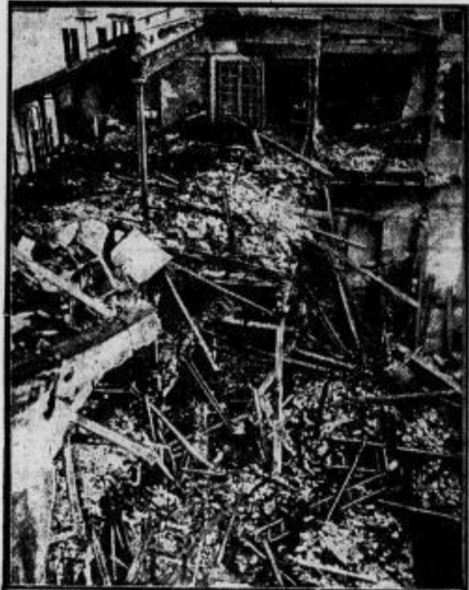
Nach dem großen Warenhausbrand in Barcelona, der das größte Warenhaus der katalonischen Hauptstadt zerstörte: ein Bild auf die Trümmerstätte des voll-kommen ausgebrannten Gebäudes.
