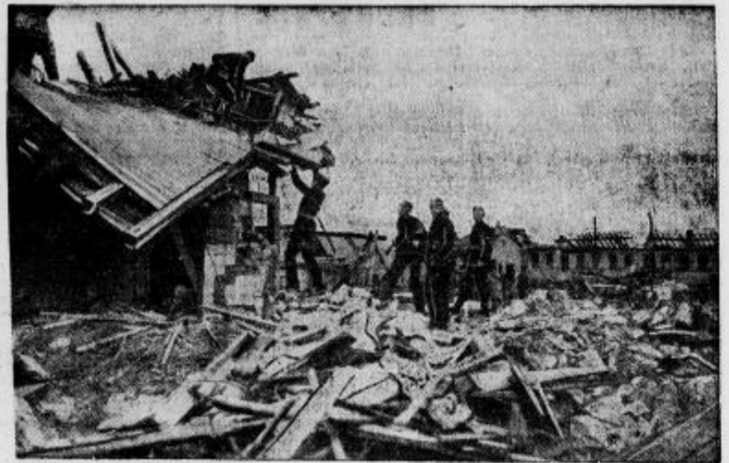
Bergungsarbeiten. Feuerwehrleute suchen nach Toten und Verletzten, die unter den Schuttmassen begraben liegen.
