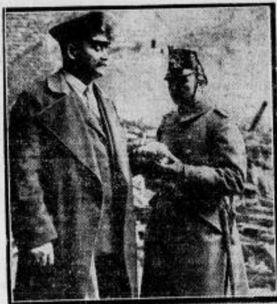
Er rettete die wertvollen Gobelin's aus dem brennenden Reichstagsgebäude. Bei dem furchtbaren Brand im Reichstagsgebäude hat sich der Oberverwaltungssekretär des Reichstages, Szranowich, durch eine besonders mutige Tat besondere Verdienste geholt: er rettete aus einem ver Rauchten Raum mehrere äußerst wertvolle Gobelin's. Hier zeigt er einem Polizisten die Armverletzung, die er sich bei seiner Rettungstat zugezogen hat.
