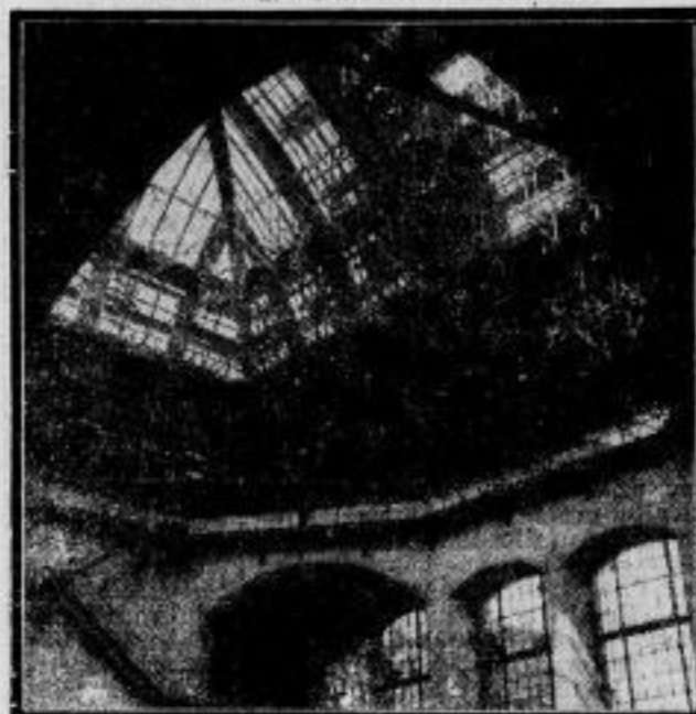
Wiederanbauarbeit am Reichstagsgebäude.
