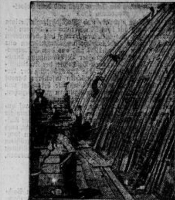
Abschluß der Aufräumungsarbeiten im Reichstag. Die Aufräumungsarbeiten im Reichstag sind beendet und die Erneuerungsbauten an der Kuppel sind jetzt mit dem Einsetzen der Glasscheiben — das in unserm Bilde dargestellt ist — gleichfalls ihren Abschluß.
