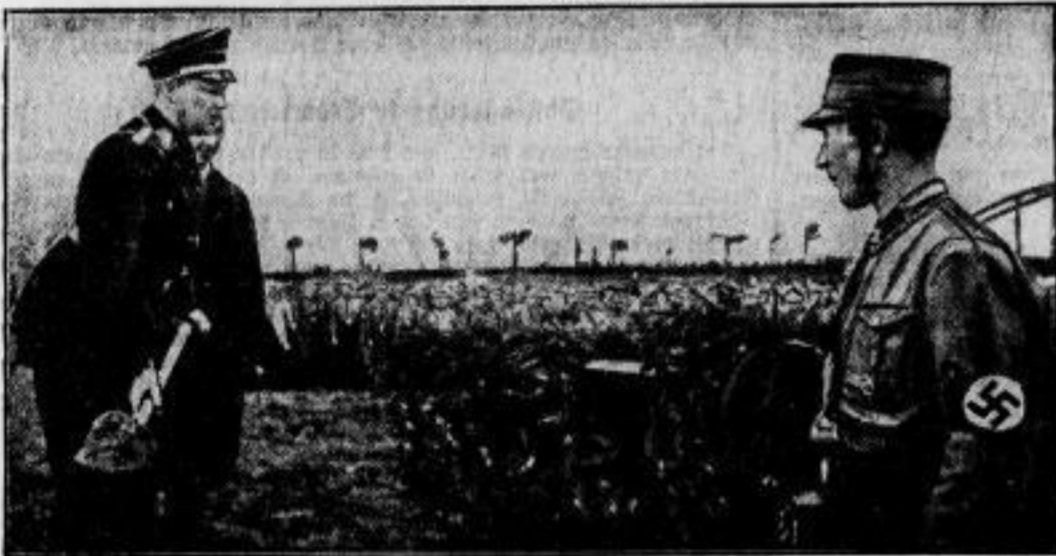
Der erste Spatenstich am Eiderdamm. In Friedrichstadt an der Eider wurde das große Restorationswerk der Eiderabdämmung mit einem Festakt geweiht, bei dem Reichsernährungs- und preussischer Landwirtschaftsminister Darré den ersten Spatenstich vollzog. Es handelt sich bekanntlich bei diesem großen Plan darum, 85 000 Hektar wertvolles Landes der Eiderniederung vor den Sturmfluten der Nordsee durch einen gewaltigen Eiderdamm bei Nordfeld sowie durch Verbesserung der Deiche zu schützen.
