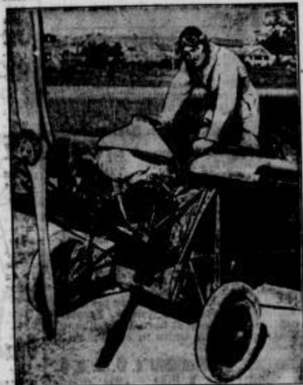
Das Dampf-Flugzeug. Zwei Amerikaner haben dieses Flugzeug gebaut, dessen Motor nicht, wie üblich, mit Benzin angetrieben wird, sondern der mit Dampftrieb arbeitet. Zur Erhitzung des Wassers für die Dampferzeugung dient Kohöl, das eine besonders günstige Ausnutzung ergibt.
