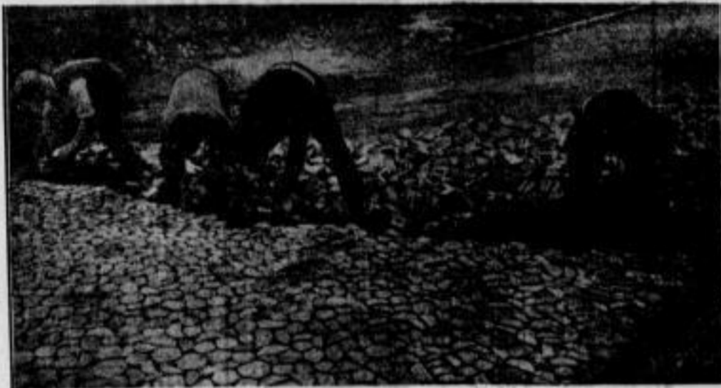
Die Straße aus Steinholz. Auf einer Berliner Fernverkehrsstraße werden gegenwärtig Versuche mit einem Holzpflaster gemacht. Wie man sieht, werden gleichmäßig geschnittene Holzstücke zur Pflasterung der Straße verwendet.
