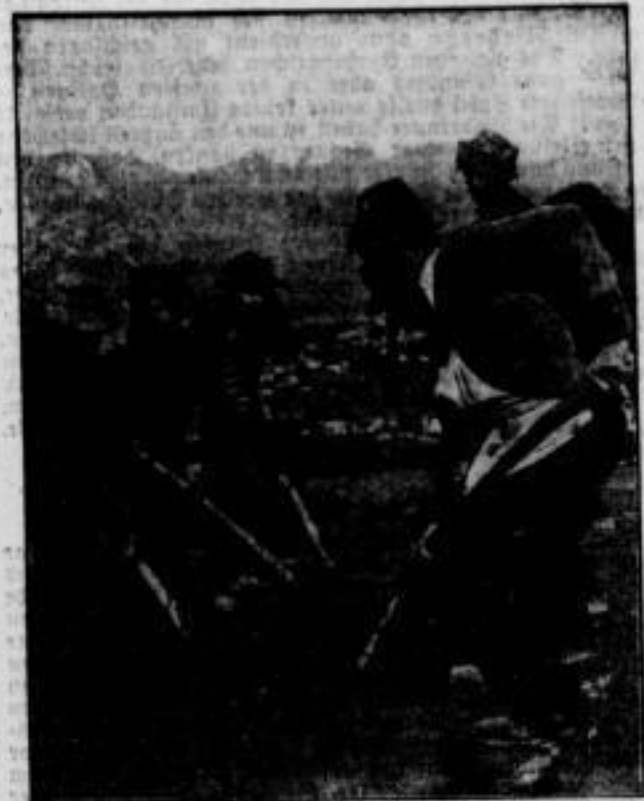
Vom Bau der Olympiasprunghänge in Partenkirchen. Die Vorbereitungsarbeiten zu den Olympischen Winterspielen 1936 sind in Garmisch-Partenkirchen in vollem Gange. Hier sieht man Einheimische beim Bau der Sprunghänge auf dem Gudi-Berg, die als größte Schanze der Welt anzusehen ist. Ihr Neigungswinkel beträgt 83 bis 40 Grad, die Sprungweite 90 Meter. Der Riesenansturm von 90 Meter Höhe steht einzig in der Welt da, und man hofft, bereits im Januar die ersten Probepfänge dort durchzuführen.
