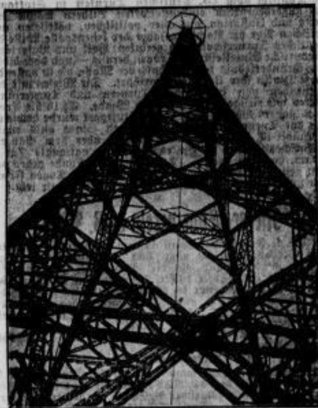
Deutschlands neuester Großsender. Die neue Großsender-Fegelei bei Berlin nimmt am 1. Dezember dieses Jahres seinen Sendebetrieb auf. Der Blick in den Sendeturm gibt einen Begriff von der Höhe dieses aus Holz ausgeführten Bauwerkes; interessant ist die Antenne, die hier innerhalb des Turmes von der Spitze senkrecht bis zur Erde reicht.
