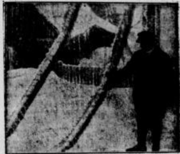
Schwere Unwetterverhältnisse im Erzgebirge. Die Gegend des oberen Erzgebirges ist in den letzten Tagen durch starke Raufreifbildung schwer heimgesucht worden; die ungeheure Belastung der Eismassen wurde von Fernspreitleitungen und Hochspannungskabeln nicht ausgehalten, so daß überall die Leitungen rissen und Masten umgeleiert wurden. Dieses Stimmungsbild aus der heimgesuchten Gegend berichtet von den verheerenden Folgen des Unwetters.
