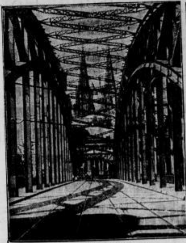
Moderne Technik und alte Kunst. Eine interessante Aufnahme des Kölner Doms, durch die Gitter der Hohenzollern-Brücke gesehen.
