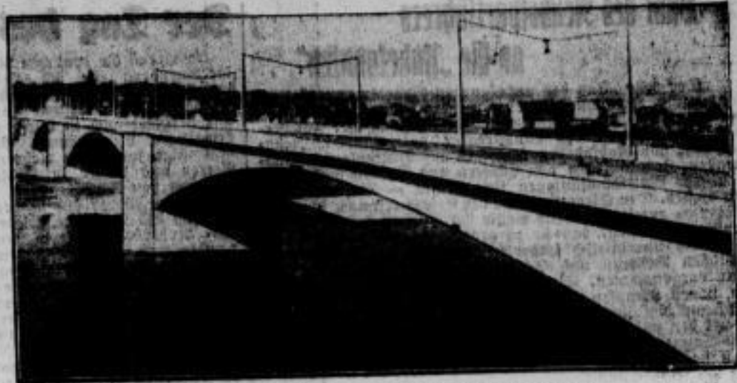
Die größte Betonbrücke Europas vor der Einweihung Am 22. April wird nach 2 1/2-jähriger Arbeit die größte Betonbrücke Europas, die Adolf-Hitler-Brücke, von Koblenz nach Rülz über die Mosel fertiggestellt und feierlich eingeweiht.
