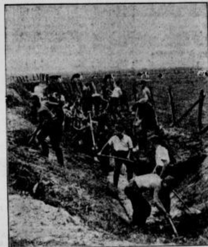
Beim Bau von Entwässerungsgräben
